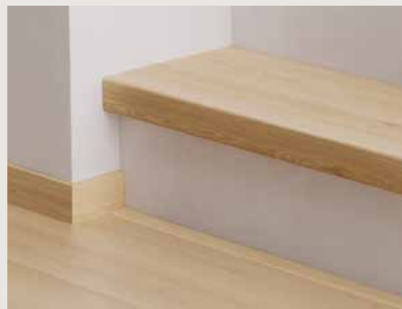
LEGGING AV MALBARE OPPTRINN Legg bare trinnene og mal resten i samme farge som veggen.
